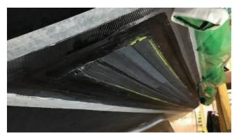
フォームによる補強の作業が完了したら、カーボン表面を研磨し、 プライマーという下地剤を塗布したうえで塗装。
